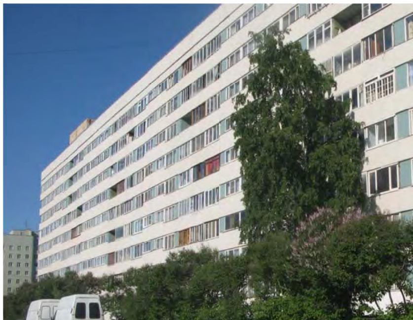
Рис. 3. Здание серии ЛГ-600. Наружные стены из автоклавного газобетона. 1970-е, Санкт-Петербург, ул. Ушинского, 5
