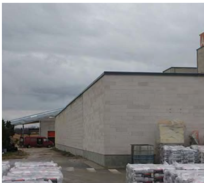
Рис. 4. Завод по производству автоклавного газобетона со стенами из неотделанной кладки, 2002 г.п., Эстония, волость Сымеру
